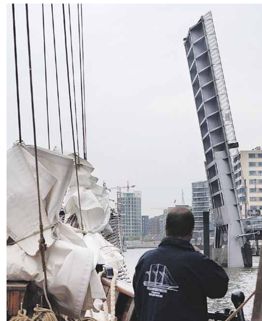
Bald für mindestens ein Jahr Baustelle – die Klappbrücke (Foto: MK)
