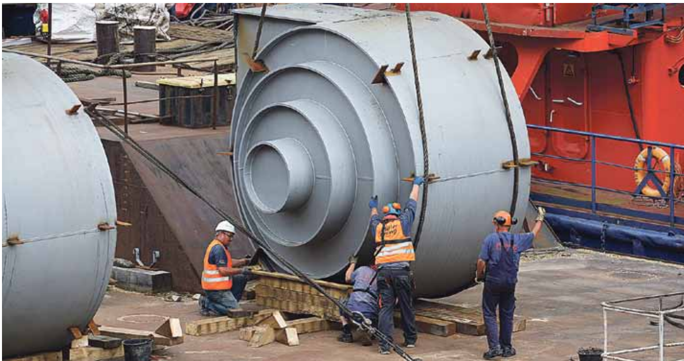
Abbau der Gegengewichte der Sandtorhafen-Klappbrücke (Foto: TH)
