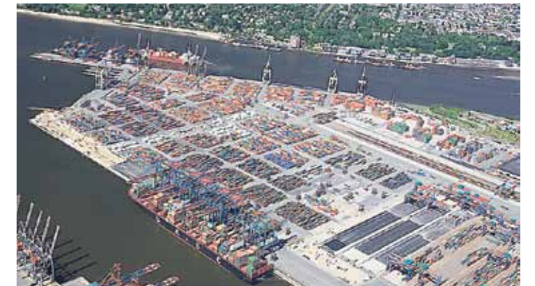
1,4 Kilometer neue Kaimauern erwarten jetzt die Schiffe (Foto: HPA)
