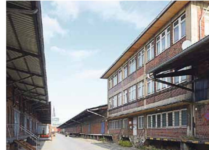
Der Oberhafen liegt noch im Dornröschenschlaf (Foto: TH)
