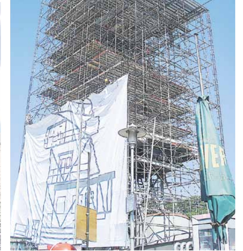
Der historische Schwimmkran wird renoviert
