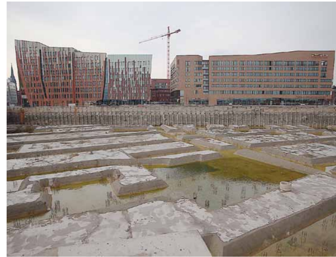
Die nach einem Jahr Stillstand renaturisierte Baugrube des südlichen Überseequartiers (Foto: MK)
