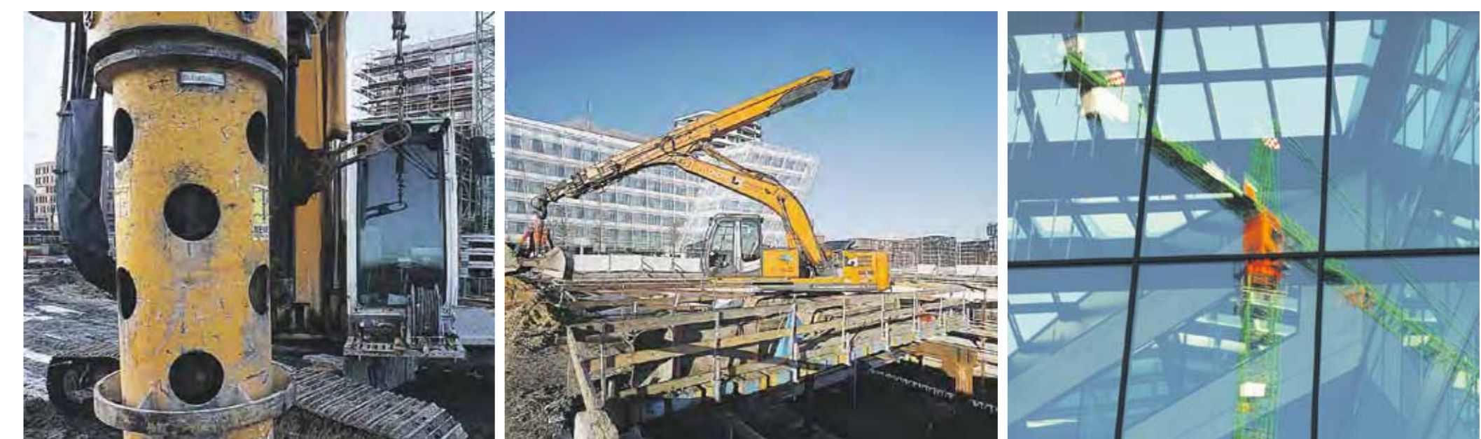
Baugeräte wohin das Auge blickt (Fotos: TH)
