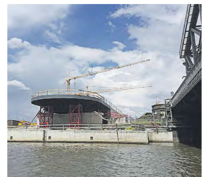
Baustelle der U4 (Foto: MB)
