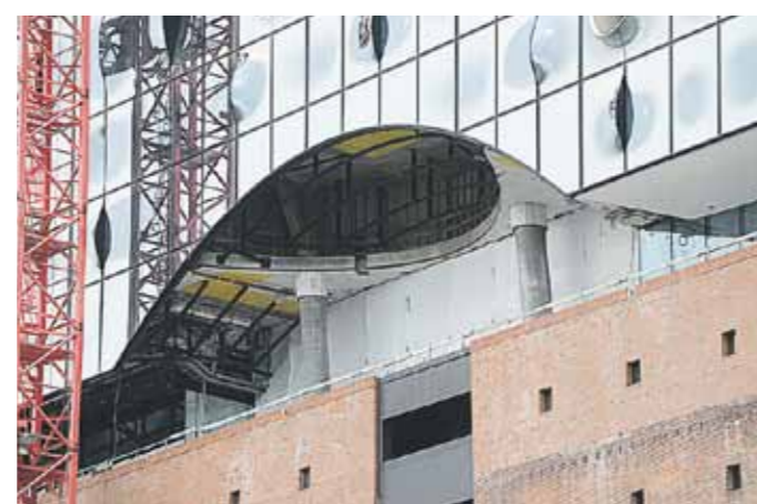
Ein Fassadendetail der Elbphilharmonie (Fotos: TH)
