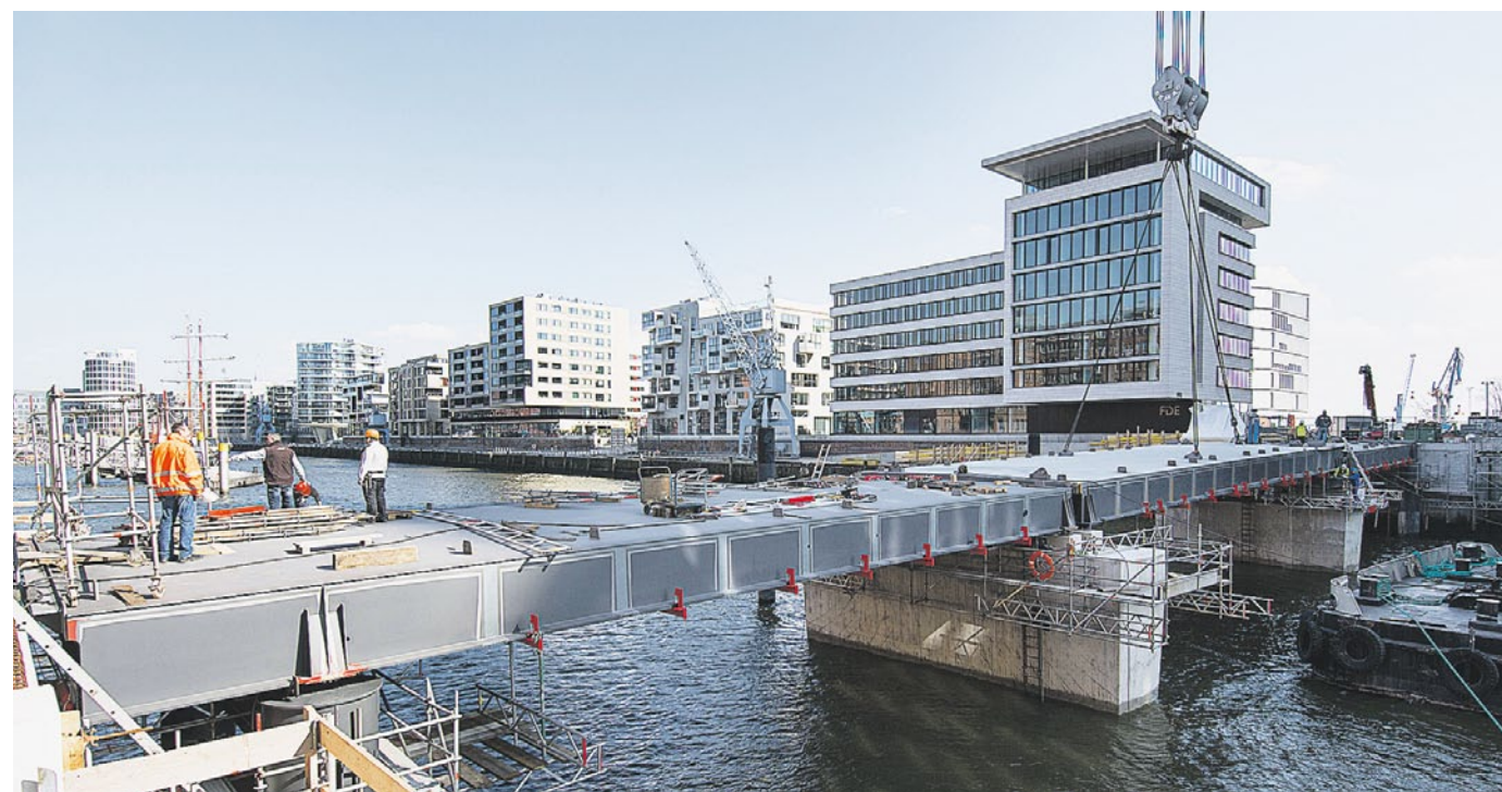
Der Brückenbau kommt gut voran (Foto: Thomas Hampel)
