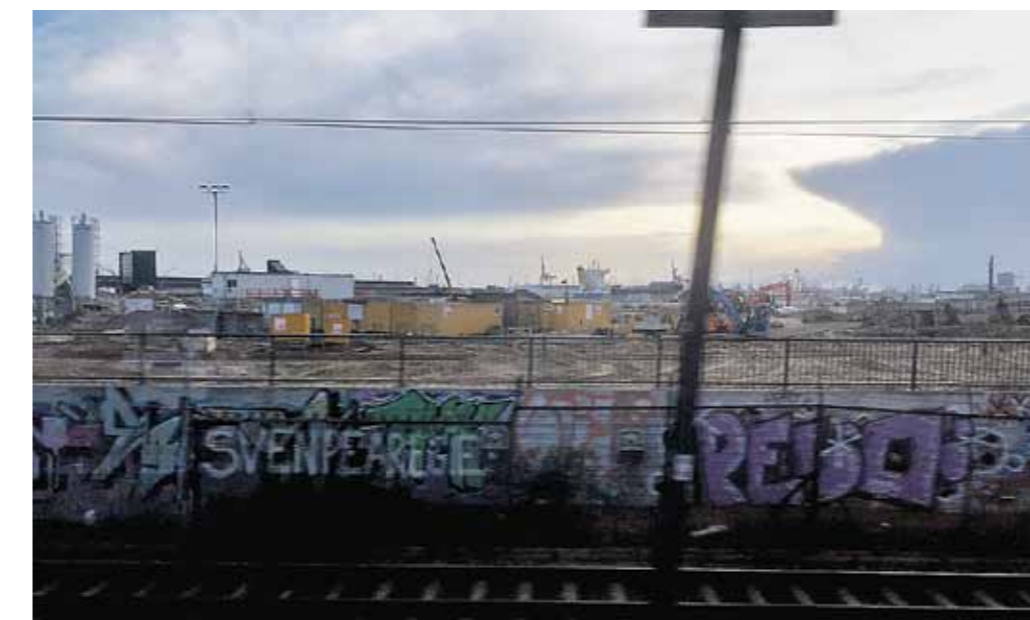
Mit den vorbereitenden Erdarbeiten wurde bereits begonnen (Foto: MB)
