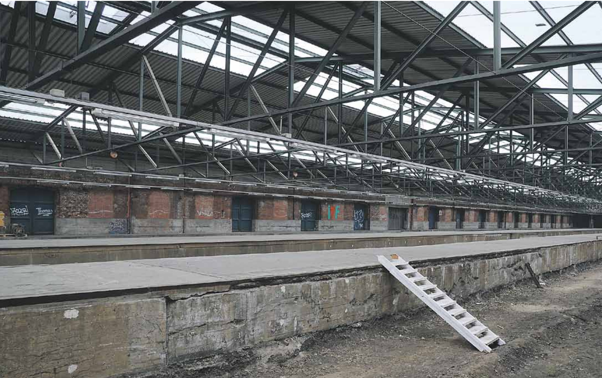
Die Güterbahnhofshalle im Oberhafen (Fotos: TH)
