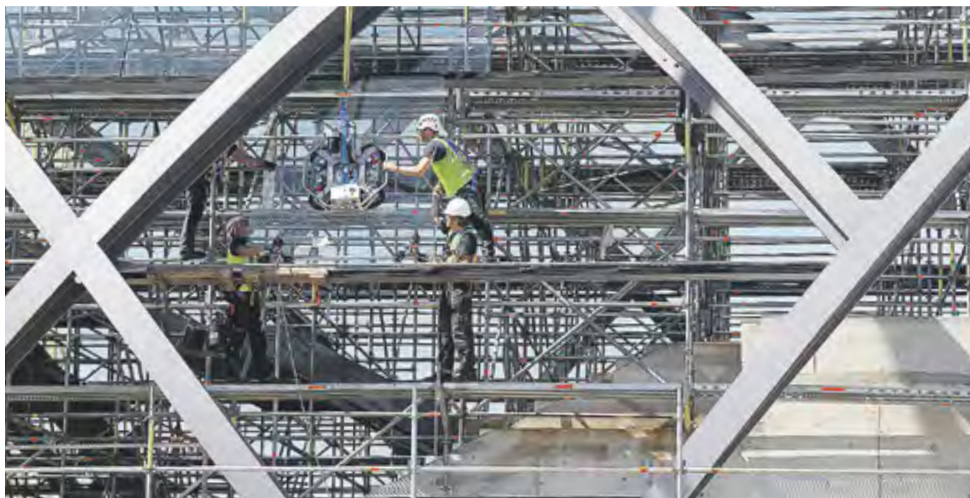
Der ÖPNV allein wird das Verkehrsproblem nicht lösen – hier die U-Bahn-Station Elbbrücken (Foto: TH)
