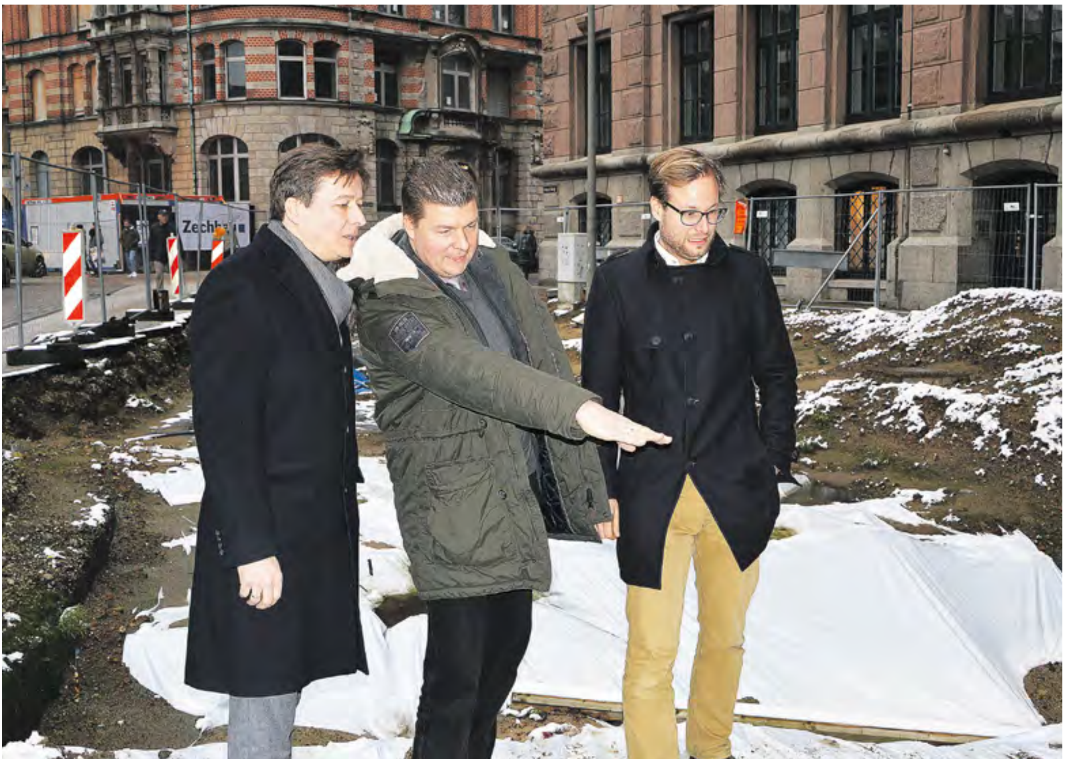
v.l. Dr. Rainer-Maria Weiss zeigt Andreas Dressel und Anjes Tjarks die Fundstelle an der Straße Neue Burg (Foto: TEN)
