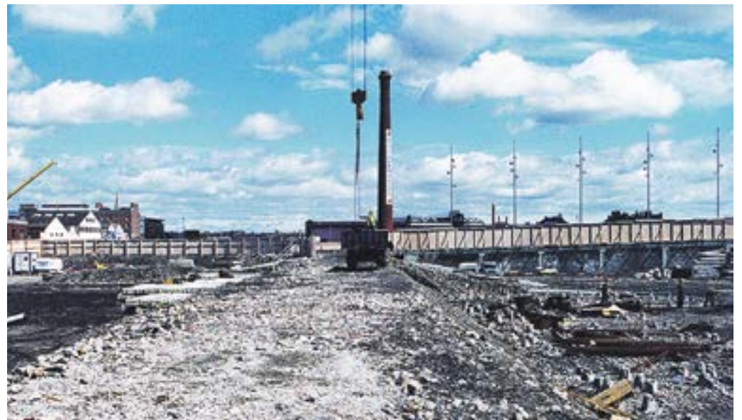
Dekontamination des Geländes der ehemaligen Gasfabrik im Jahr 2003
