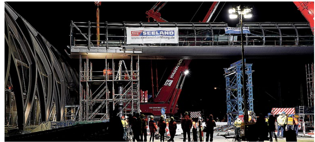
In zwei Nachtschichten wurde der Skywalk eingehängt, der Bahnverkehr musste ruhen (Foto: TH)
