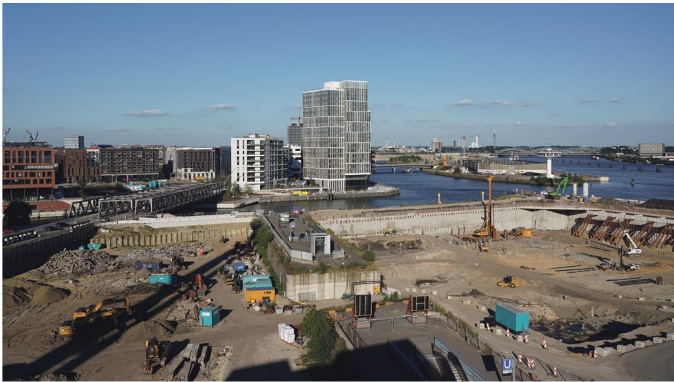
Aus Richtung Grasbrookpark eröffnet sich die gigantische Dimension der Baugrube (Foto: TH)
