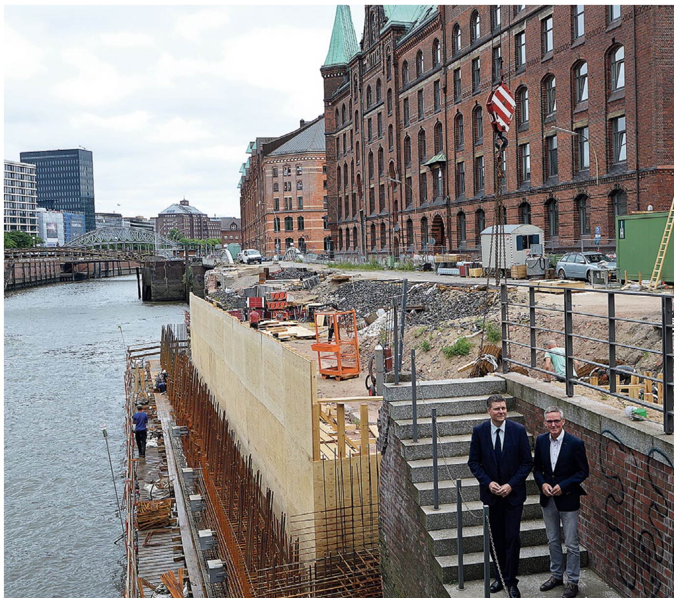
v.l. Finanzsenator Andreas Dressel und LIG-Geschäftsführer Thomas Schuster besichtigten vor Ort die Bauarbeiten der Kaimauersanierung im Zollkanal. (Foto: TEN)
