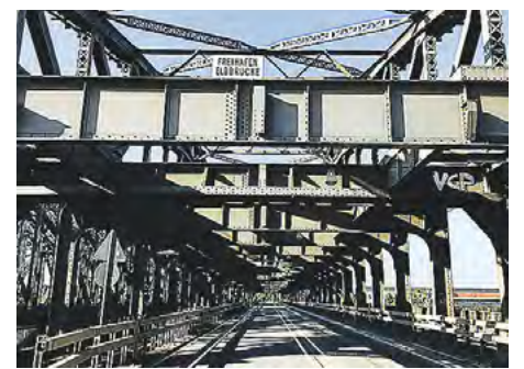
Nahverkehr auf Effizienz trimmen – Die Idee gab es schon vor 100 Jahren mit einer doppelstöckigen S-Bahn Trasse in den Elbbrücken (Foto: J. Munzinger)
