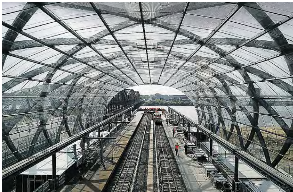
Die Einfahrt in den Bahnhof Elbbrücken bietet ein spektakuläres Bild (Foto: TH)
